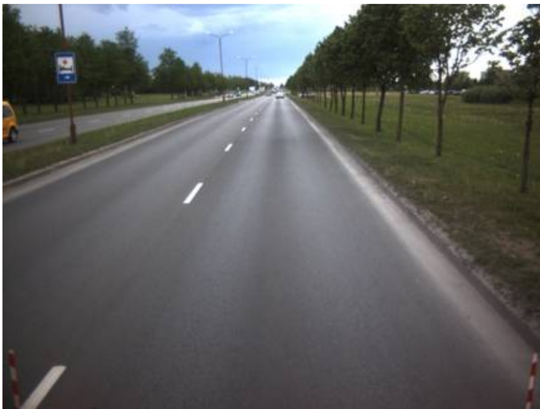
2.29 pav. Labai gera dangos būklė pagal suminį dangos būklės indeksą (0,90 - Architektų g. (19) B2, kryptis 1, ruožas nuo 0 m iki 160 m)
