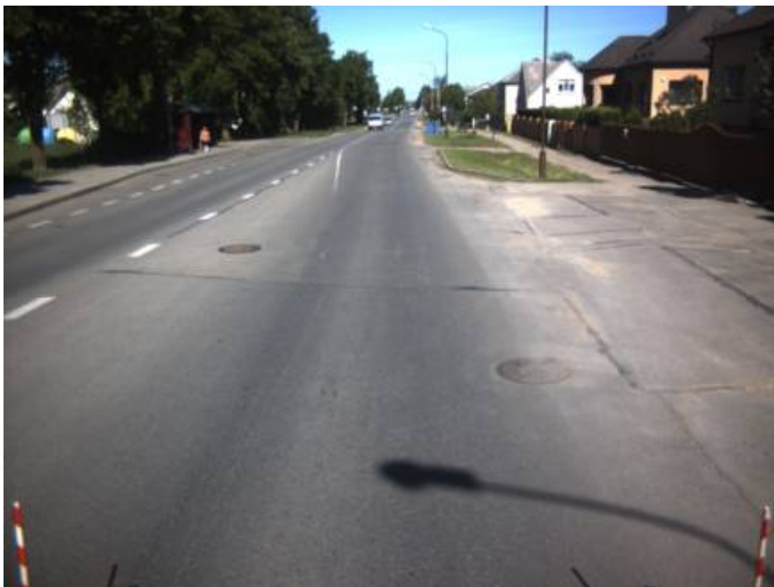
2.27 pav. Vidutinė dangos būklė pagal suminį dangos būklės indeksą (2,90 - Birutės g. (43.2) C2, kryptis 1 ir 2, ruožas nuo 1000 m iki 1120 m)
