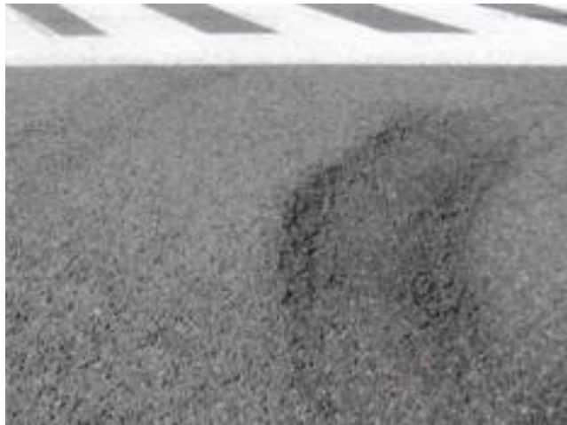
2.6 pav. Slinktys asfalto dangoje
