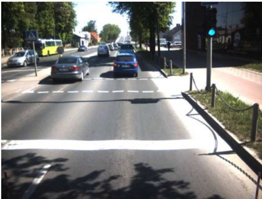
2.26 pav. Vidutinė dangos būklė pagal suminį dangos būklės indeksą (2,94 - Tilžės g. (258.3) C1, kryptis 1, ruožas nuo 480 m iki 590 m)
