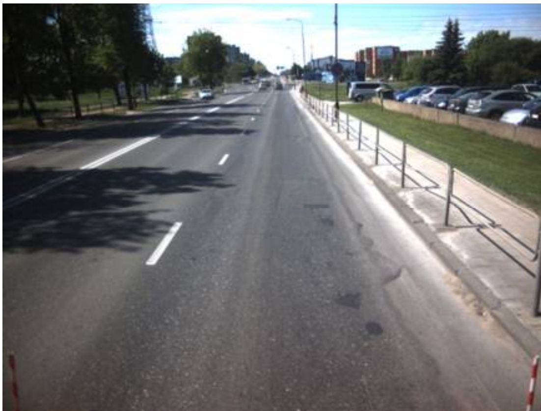
2.24 pav. Bloga dangos būklė pagal suminį dangos būklės indeksą (3,98 - Tilžės g. (258.2) B2, kryptis 2, ruožas nuo 1070 m iki 1460 m)
