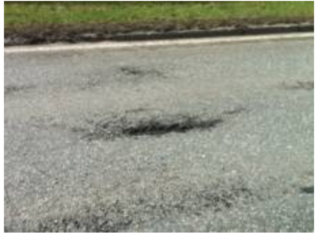
2.10 pav. Išdaužos asfalto dangoje
