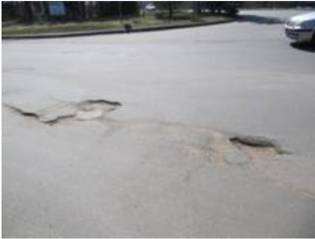
2.9 pav. Duobės asfalto dangoje
