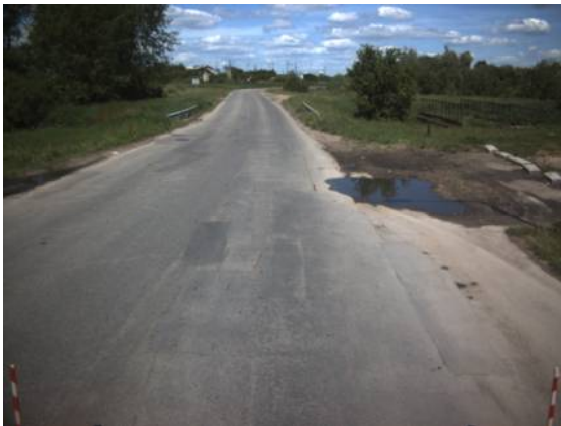
2.25 pav. Bloga dangos būklė pagal suminį dangos būklės indeksą (3,32 – J. Basanavičiaus g. (113.2) C1, kryptis 1 ir 2, ruožas nuo 2630 m iki 2740 m)
