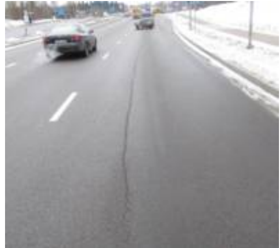
2.8 pav. Išilginis plyšys asfalto dangoje
