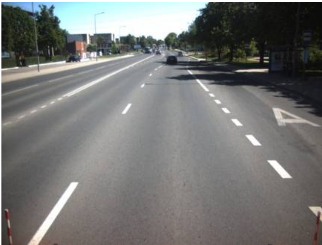
2.28 pav. Gera dangos būklė pagal suminį dangos būklės indeksą (1,62 - Tilžės g. (358.2) B2, kryptis 1, ruožas nuo 820 m iki 910 m)
