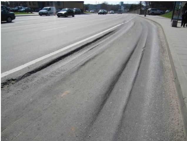
2.5 pav. Asfalto dangos provėžos
