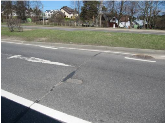
2.7 pav. Skersinis plyšys asfalto dangoje
