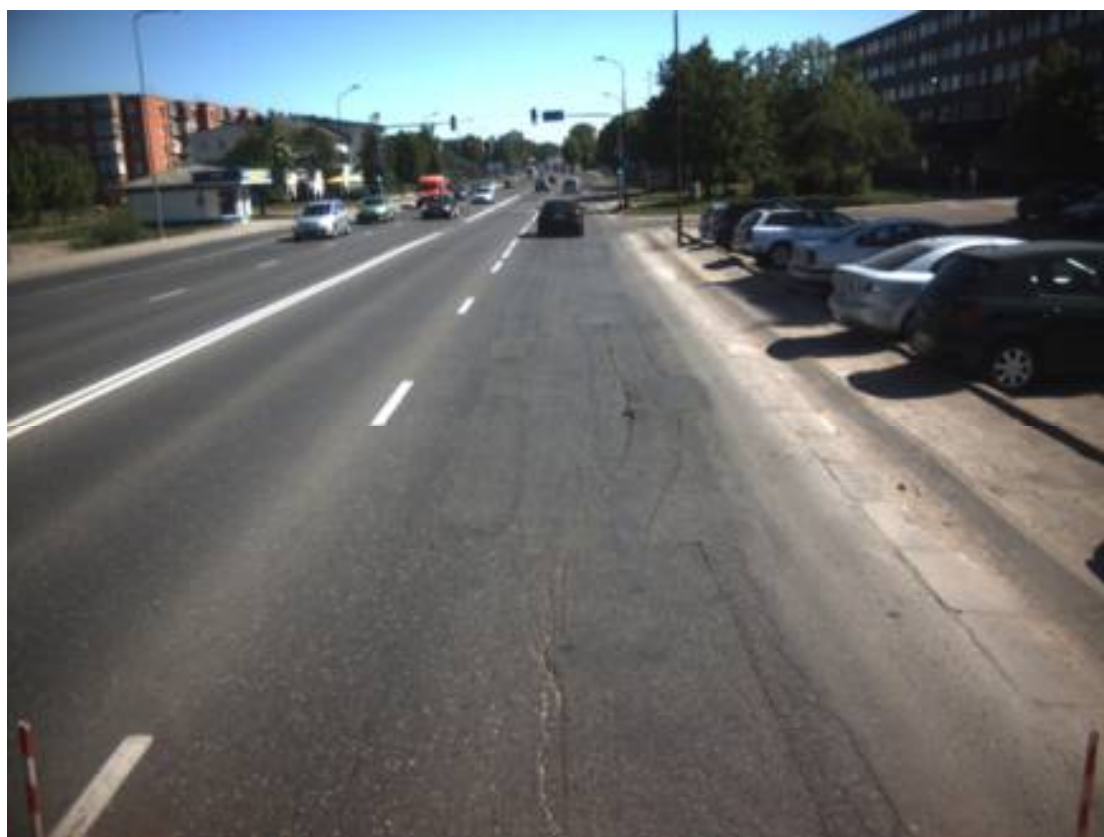
2.23 pav. Labai bloga dangos būklė pagal suminį dangos būklės indeksą (4,39 - Tilžės g. (258.2) B2, kryptis 1, ruožas nuo 710 m iki 820 m)
